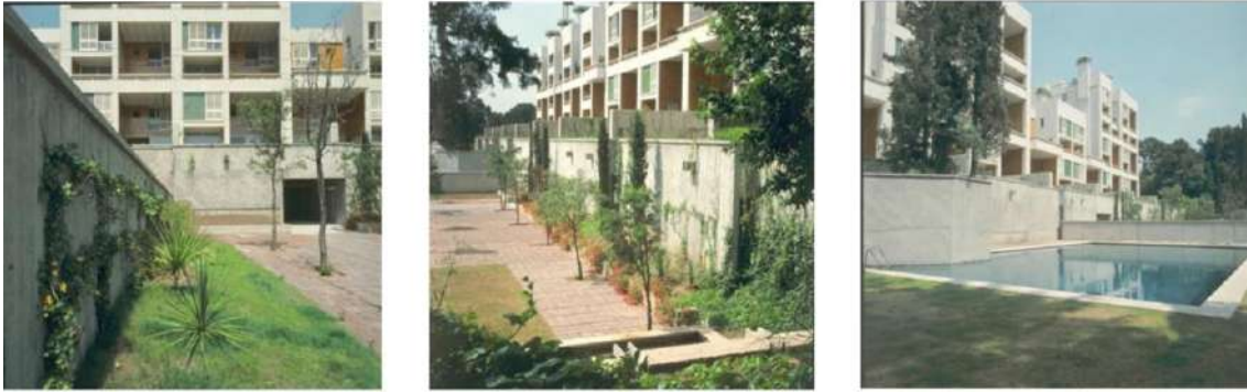
Fig. 8. Les Escales Park (1968-1973). Fotografías del patio interior (S1659, S2660, S2661). Fuente: Archivo Sert, Fundación Miró, Barcelona.
