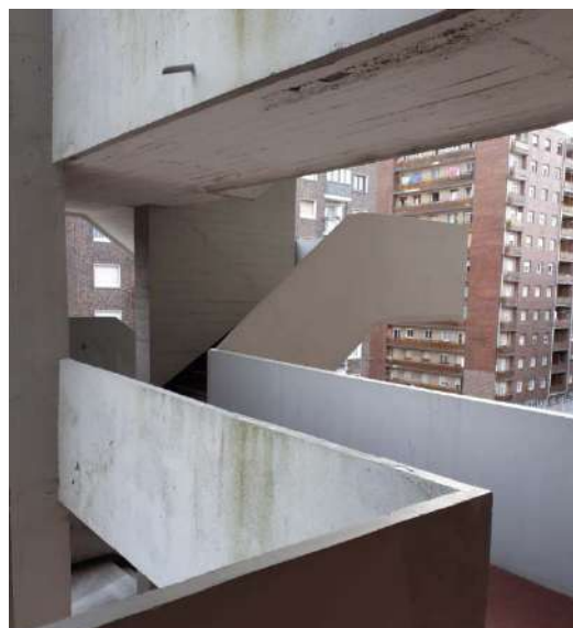
Fig. 10. Pasarela entre el rellano de los ascensores y galerías, con las escalera al fondo.
