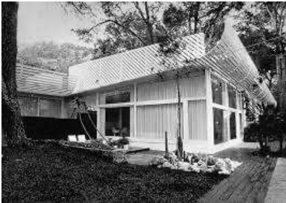
(Fig.9) Vista en escorzo de la parte nueva, con la cornisa de cuarto de caña y los testeros planos. Foto publicada en Climent, F. J. Sáenz de Oíza, Mallorca 1960-2000, 2001, pág. 56.
