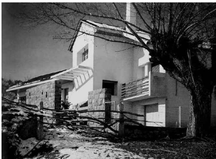
3 Casa nº6 en el Camí de Talló, Sostres
