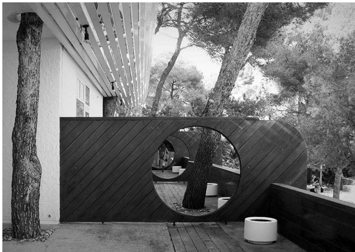
(Fig.0) Casa Huarte (Entrepinos) en Formentor. Vista de la veranda y particiones con óculos p© escuela de arquitectura Toledo eaT. Fuente: maet - Magacín de arquitectura de la escuela de Toledo eaT , "Oíza - primera parte", pp. 212-21
