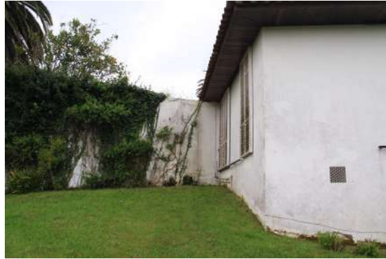
Fig.6. Prolongación muro norte ©Autor (2012)
