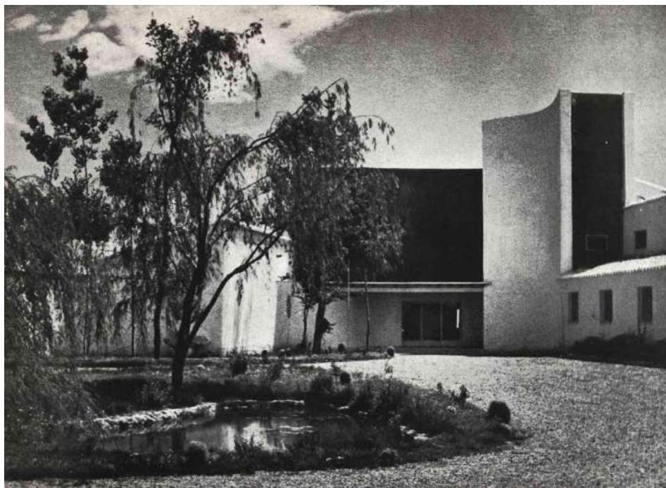
Fig. 4. Vista general del patio (1953). Archivo Fundación Miguel Fisac
