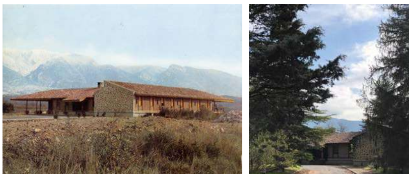
Figura 2. (a) Residencia para trabajadores temporales (1971). (b) Estado actual (abril de 2018).
