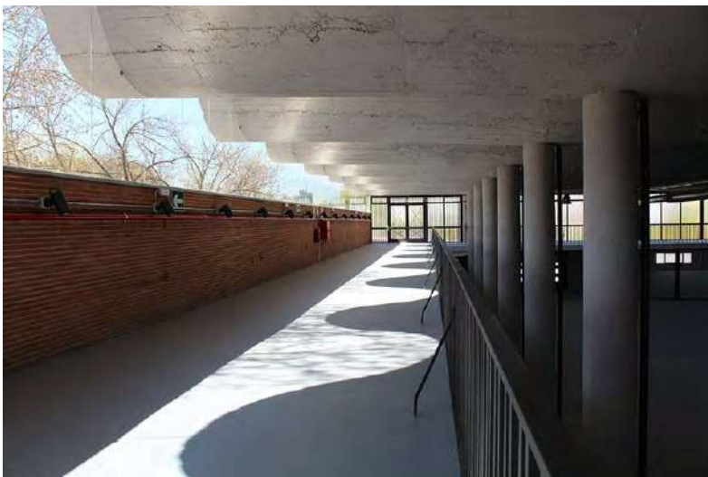
FIG. 17, 18, 19 y 20. El pabellón recuperado, 2021. Autor
