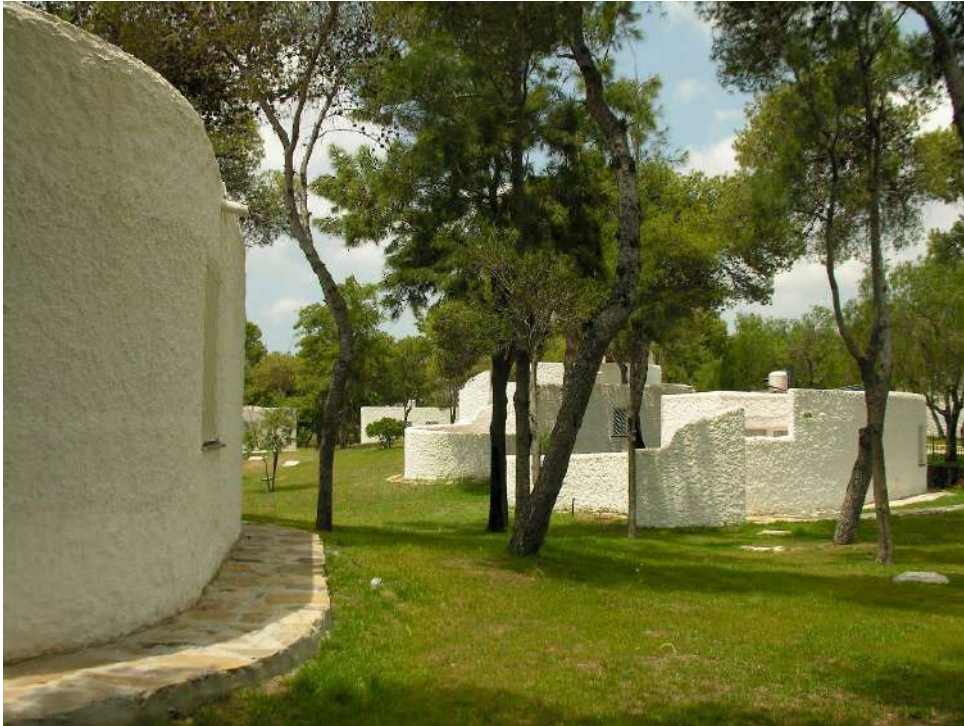
Figure 4. View of the Type D housing area. Base de Datos Patrimonio Inmueble de Andalucía.
