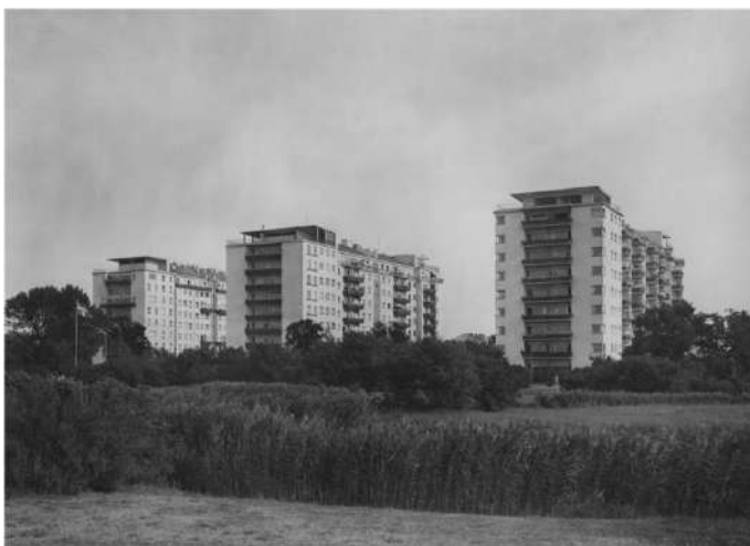
Fig. 7. Eric Sigfrid Persson. Grupo de viviendas en Ribershus (Malmö, 1937-1943). Archivo de la Ciudad de Malmö.
