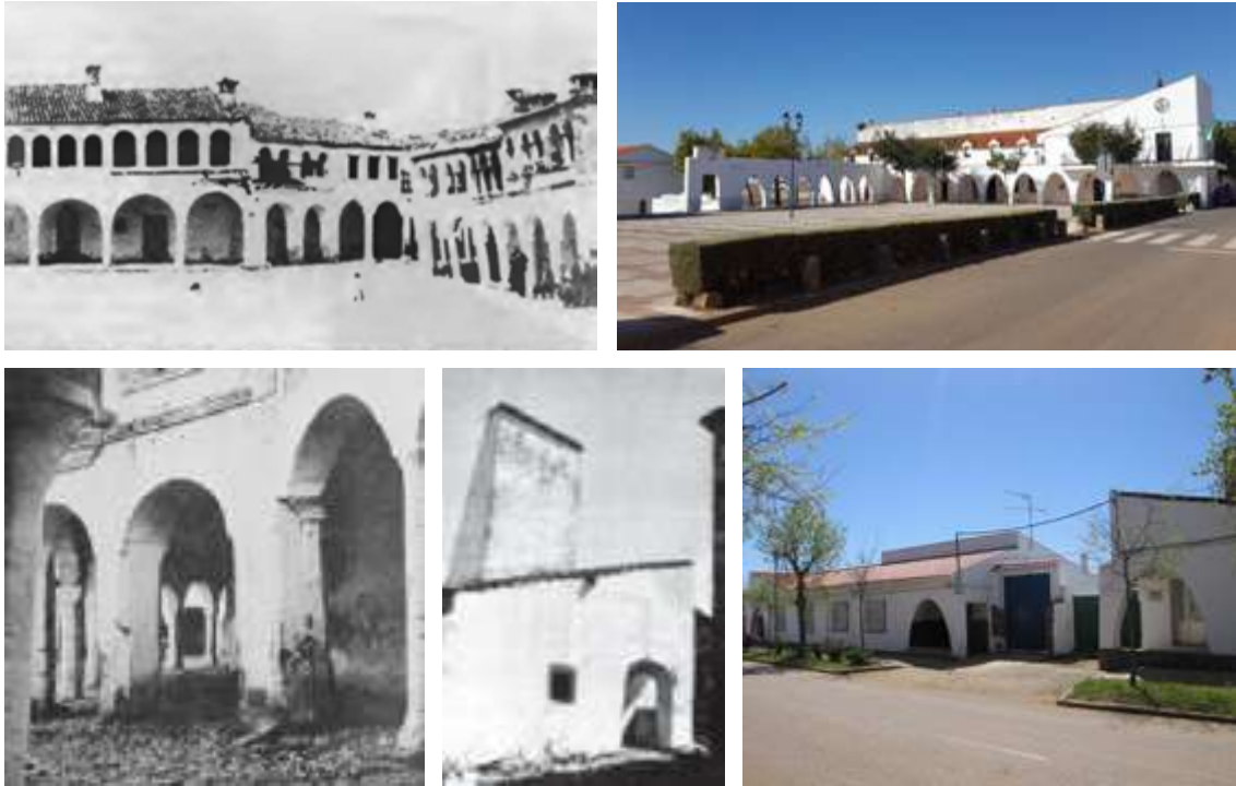
Imagen 9. 1. Plaza de Garrovillas de Alconetar (Siglo XX). Archivo Rudofsky. 2. Vista actual del Centro Cívico (2010), Autores. 3. Vista del soportal de la Plaza de Garrovillas de Alconetar (Siglo XX). Archivo Rudofsky. 4. Vivienda popular en Salvatierra de Santiago (1930). F. García Mercadal. 5. Vista actual de Viviendas Tipo C (2010). Autores.
