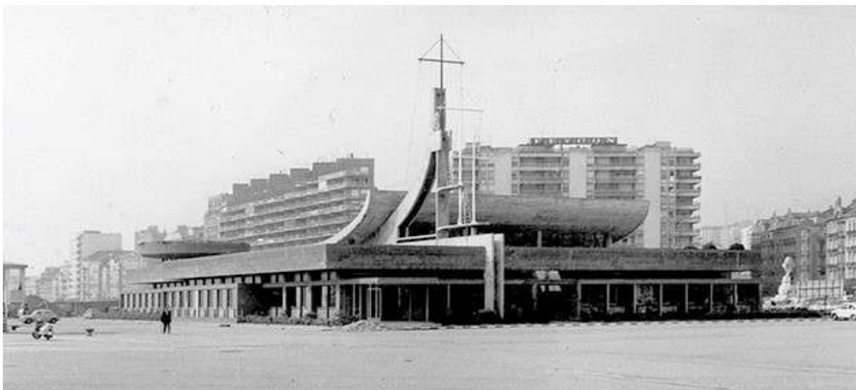
Fig. 8. Olas de hormigón y mástil de señales desde el sureste. Fuente: archivo APS.
