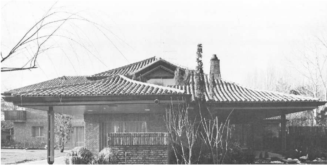
Fig. 10. Casa Lindon , 1968-70, La Florida, Madrid. Alzado posterior al jardín. Archivo José Serrano-Suñer.
