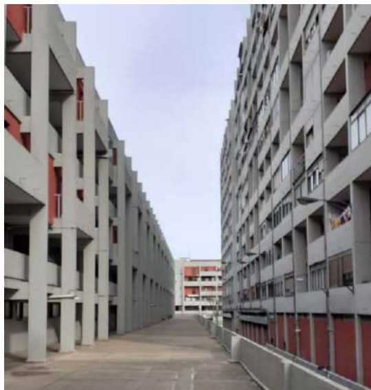
Fig. 7. Calle interior entre los dos bloques. Galerías a la izquierda; solanas y balcones a la derecha.
