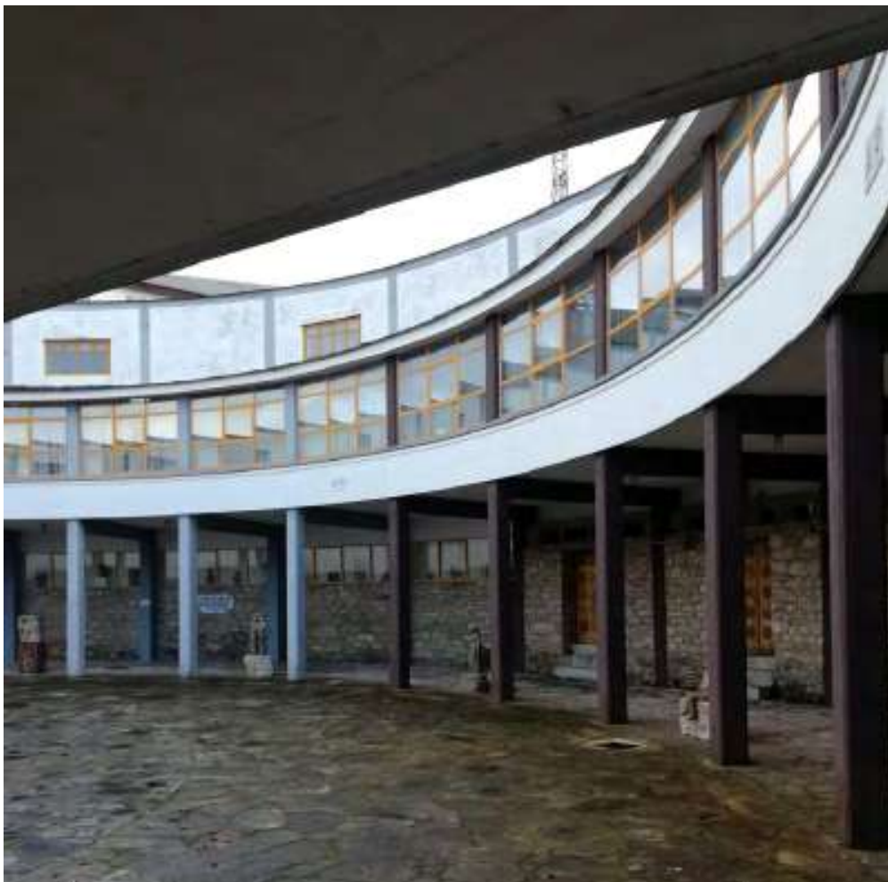
Vista actual de la Plaza Circular de Sargadelos (Fotografía propia).
