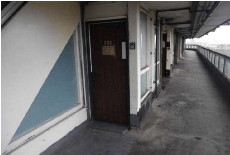
Fig. 3. Complejo residencial Robin Hood Gardens . Entrada a los apartamentos. Fotografía de Imanol Esperesate.
