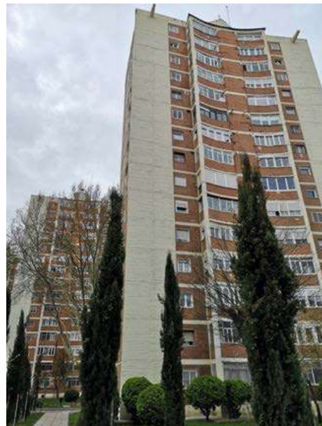
Fig. 13. Perspectiva de las torres. Nótese las gárgolas y las pantallas de hormigón visto. Fotografía del autor, 19 de marzo de 2022
