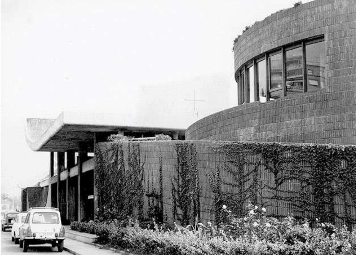
Fig. 7. Vista en escorzo de la fachada norte. La vegetación crece sobre los muros de la rampa que bordea el cuerpo cilíndrico de la cafetería. Fuente: archivo APS.
