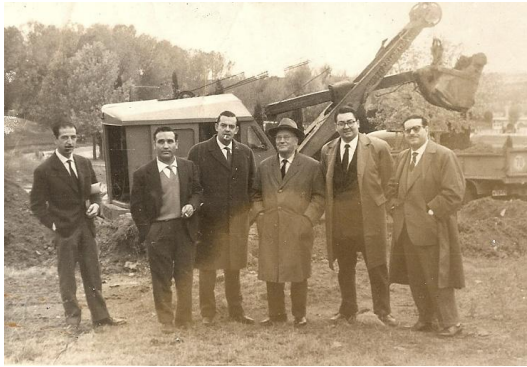
(Fig. 17). Las obras comenzaron en noviembre de 1960. En la foto de obra figuraban los protagonistas de lo que fueron las obras durante los siguientes meses: L.A. D'Escragnolle F.; Leónidas Sobrino; Alejandro Moratilla (encargado de las obras) y F. Moreno Barberá.(32)
