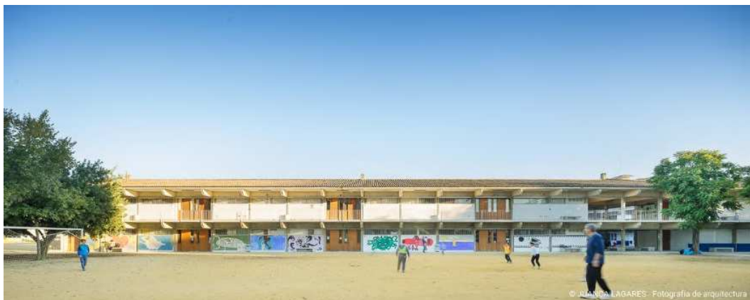
Figura 11. Fotografía del alzado del Colegio Aljarafe. Juanca Lagares.
