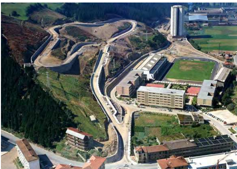
Construcción de la ladera de Olandixo, en 1970, con el campus universitario a la derecha y la Torre Eguzki al fondo.
