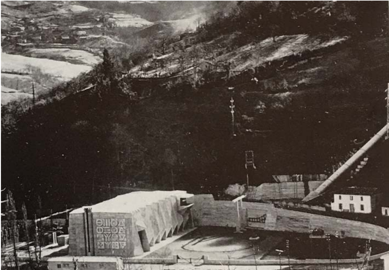
Fig 2. Emplazamiento de la Central de Proaza. Fotografía recogida en Vaquero Palacios, Joaquín. La central de Proaza, en Arquitectura , Coam, Madrid, 1970, nº137, mayo, p. 57.
