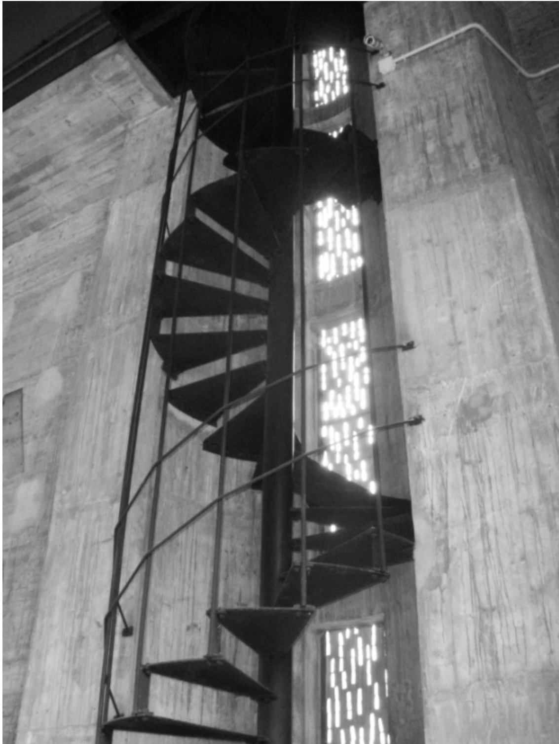
Fig.9 Interior de la Central de Proaza. Escalera de caracol. Fotografía de autores de comunicación.
