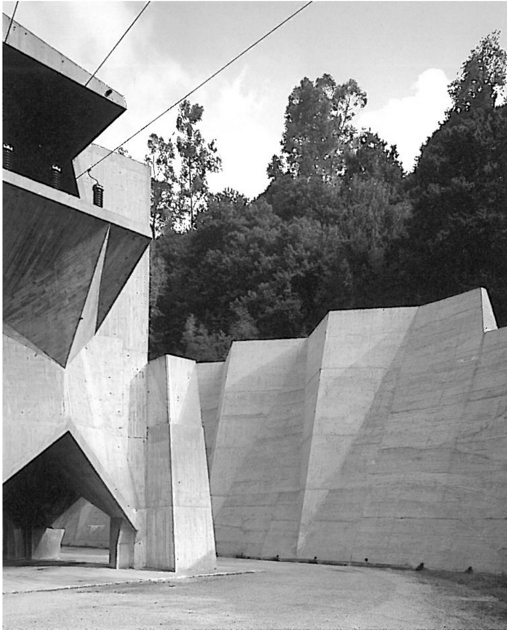
Fig.8 Alzado y muro de contención de la Central de Proaza. Fotografía recogida en Pérez de Lastra, José Antonio. Vaquero Palacios, Arquitecto. Colegio Oficial de Arquitectos de Asturias. Oviedo, 1992, p.222
