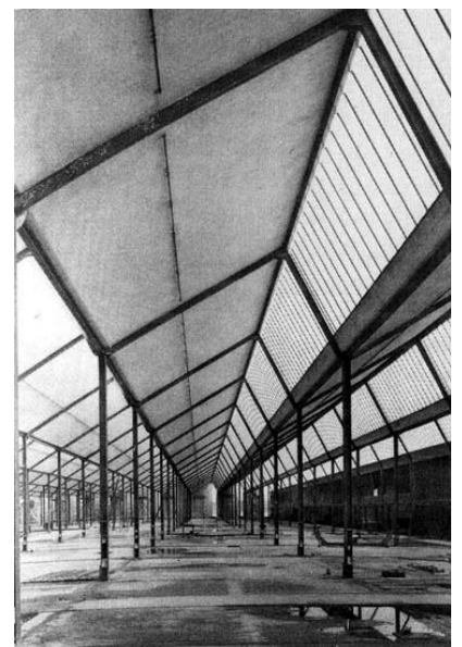
[Fig.8] Vista interior del taller grande durante su construcción (ACT).
