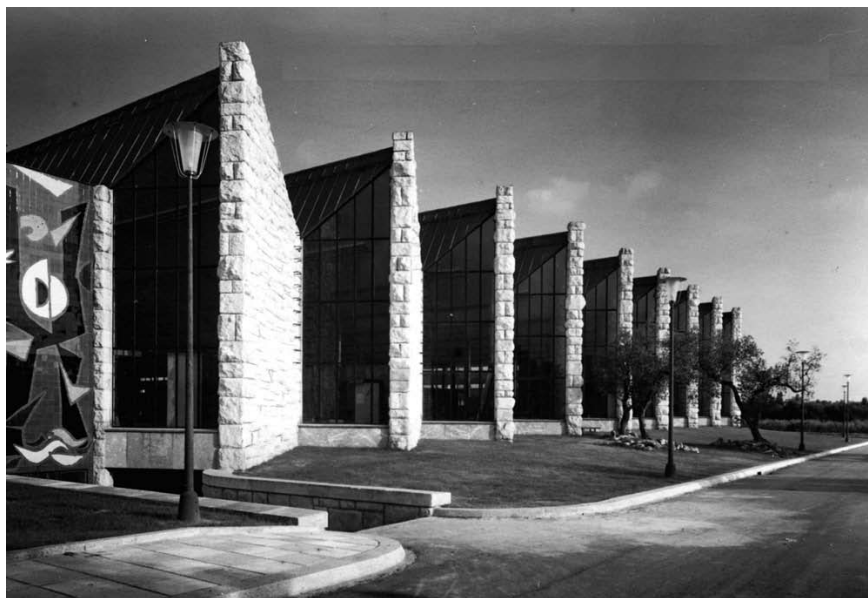
[Fig.9] Fachada lateral de los talleres donde debían ir situados los grandes murales planteados por Jorge Oteiza (ACT).
