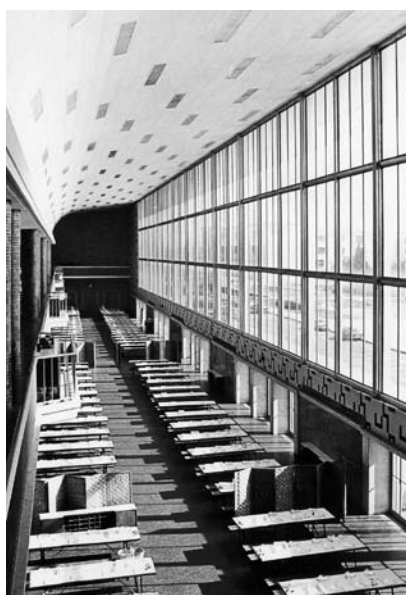
[Fig.5] Interior del comedor bajo su cubierta abovedada y abierto a la gran plaza a través de la fachada vidriada (ACT).
