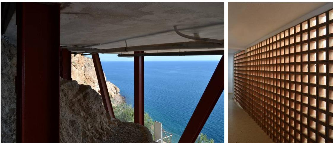
Figura 18. a) Estructura pórticos planta baja y b) celosía de los pasillos de los apartamentos del Bloque A (no construido) de la Urbanización «La Parra» (mayo de 1970). [Fotografías: JFGS].
